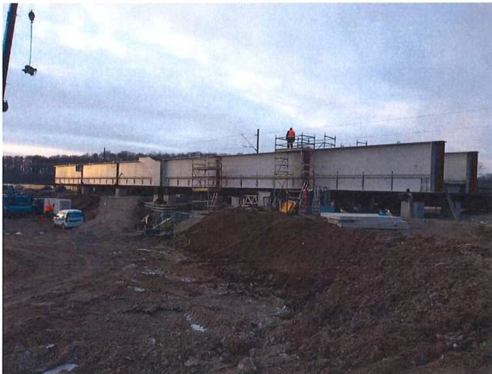
Vykládka ocelevej konštrukcie mosta a príprava na zváranie
