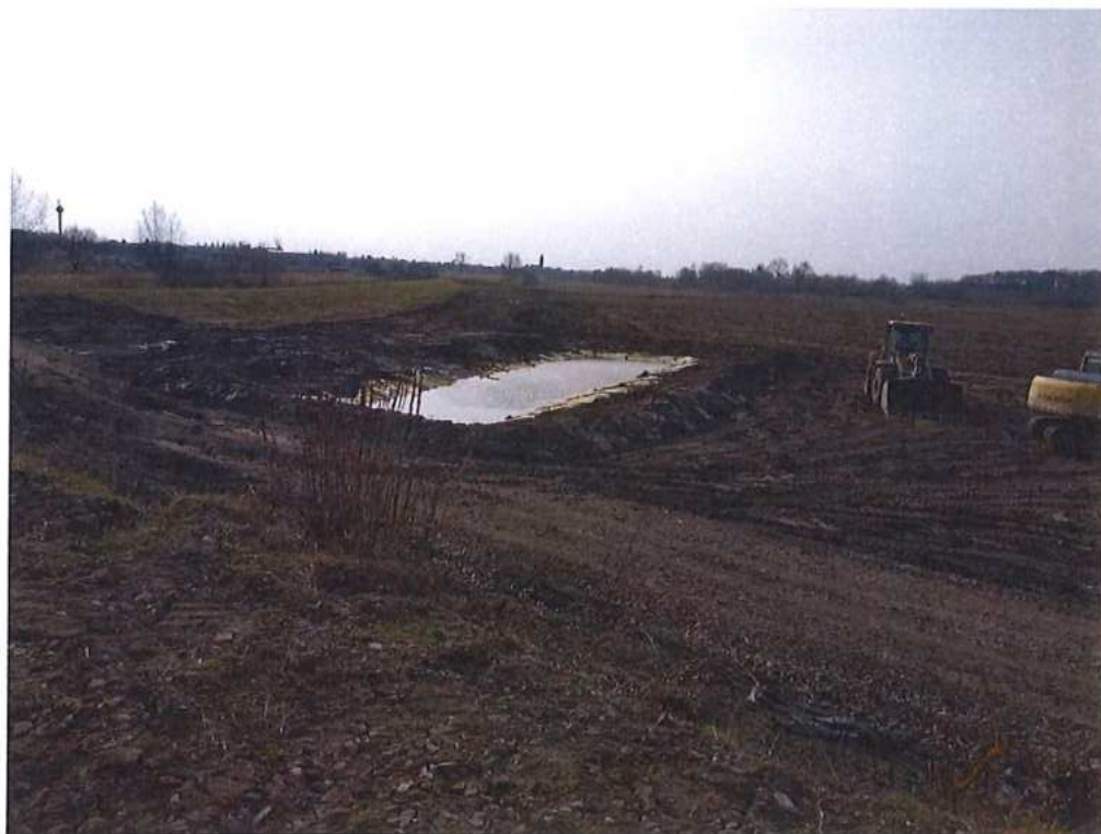
Úprava kalových jám pre tryskovú injektáž SO 12-33-01
