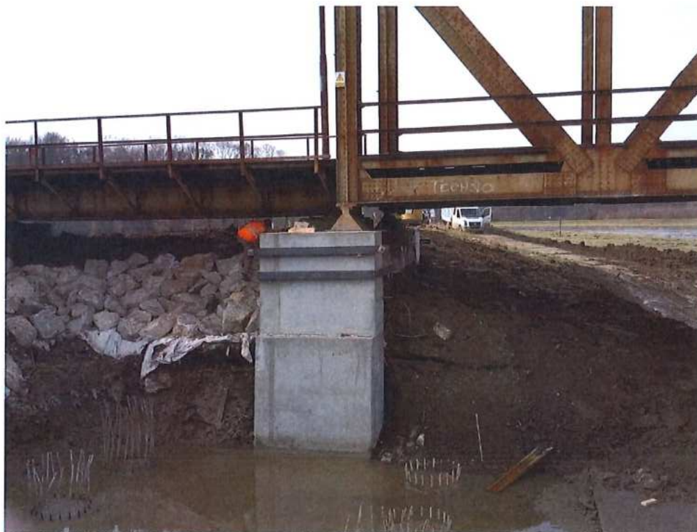
Spevnenie opory OP1 SO 12-33-04
