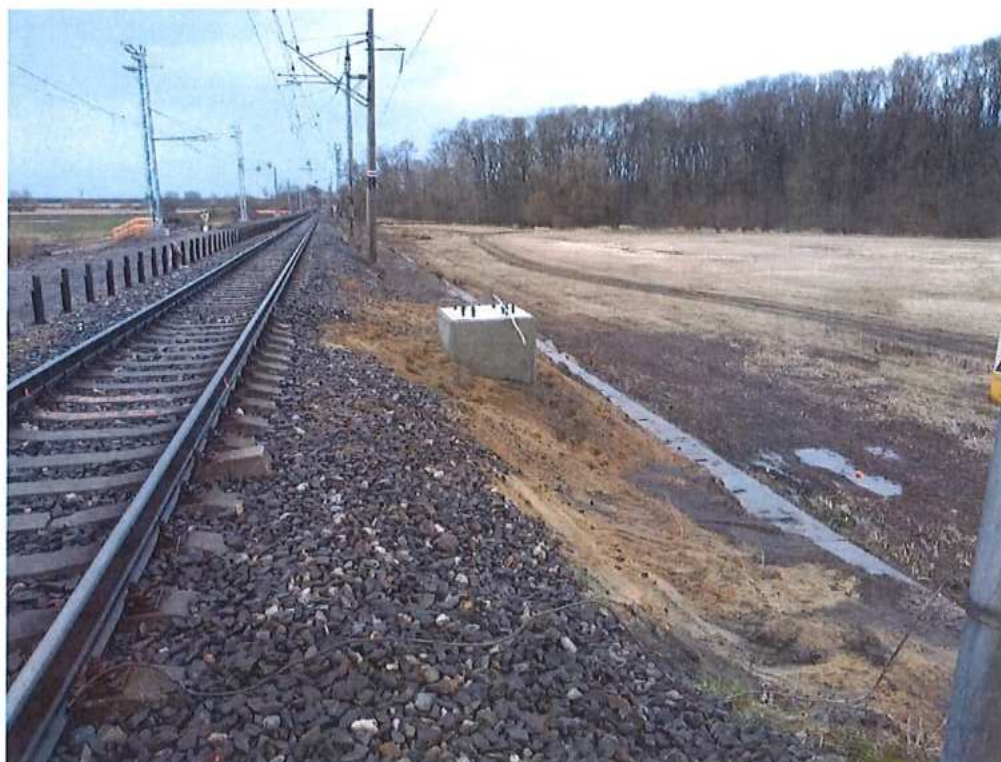
Výkop a betonáž základov TP pri koľaji číslo 1 v km 73,850 – 74,200
