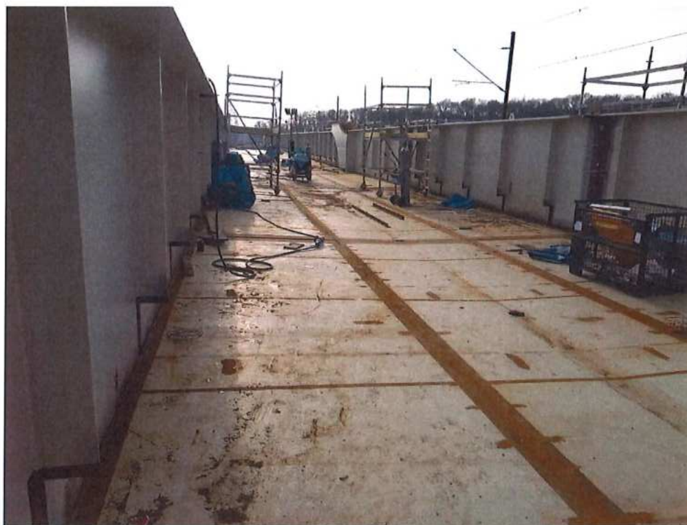
Montáž oceľovej konštrukcie mosta SO 12-33-04
