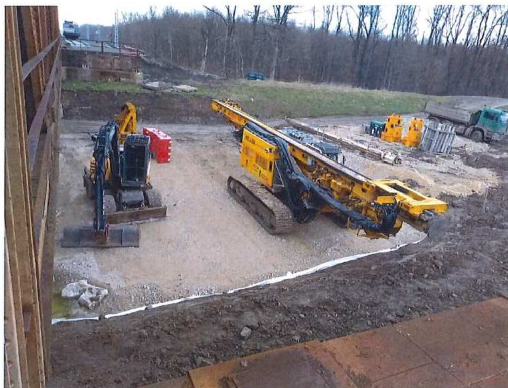
Príprava plarfotmy pre pilotáž - pilier P2 na strane CZ SO 12-33-04
