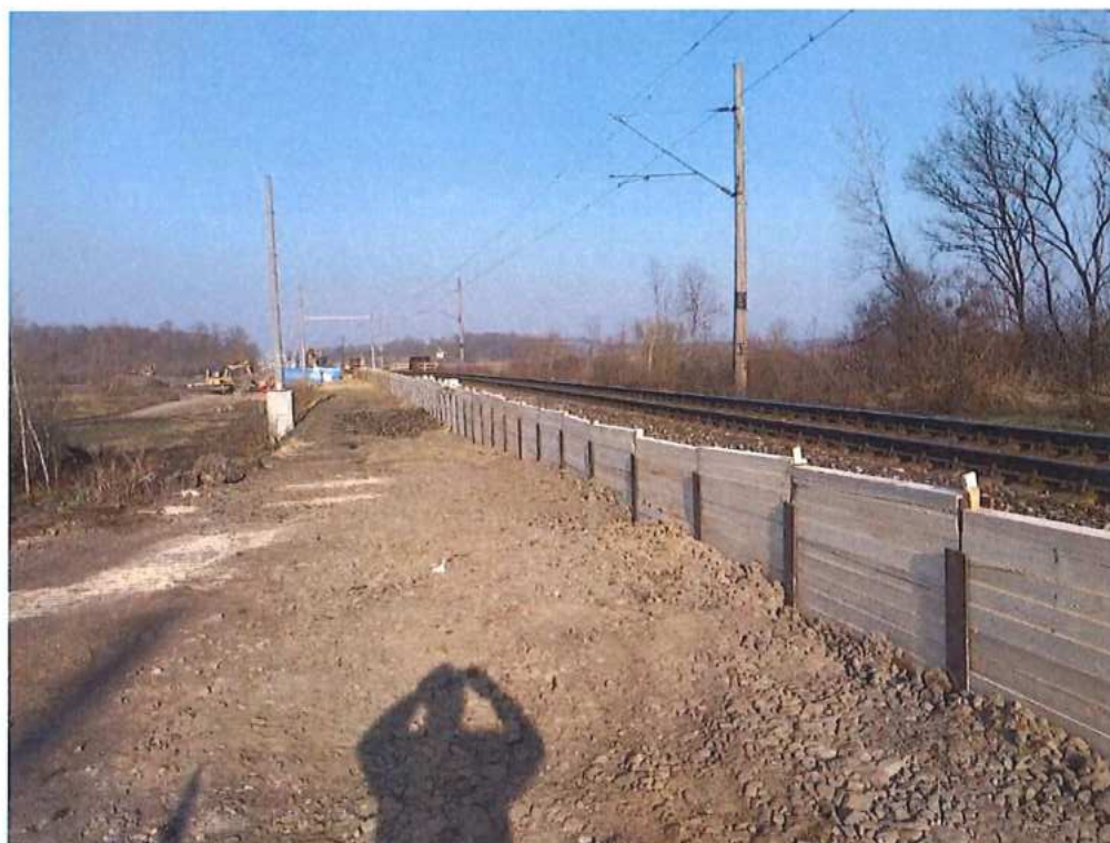
Zriadenie paženia medzi TK 1 a 2. v km 72,750-73,210
